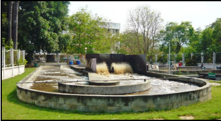
รูปที่ 3 ระบบคลองงานเวียน (Oxidation Ditch)
