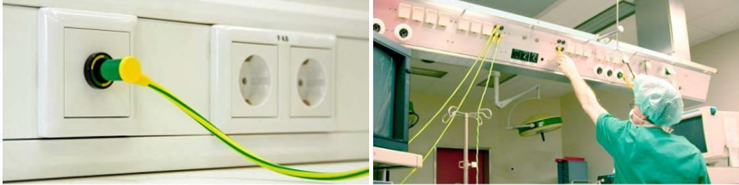
ภาพแสดงการติดตั้งกราวด์ Redundant Ground Jack
