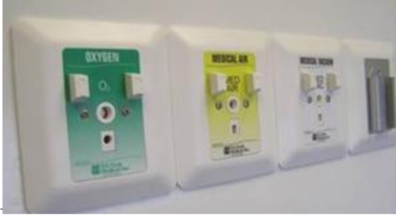
รูปที่ 7 ตัวอย่างหัวจ่ายก๊าซออกซิเจนและสุญญากาศแบบติดผนัง
