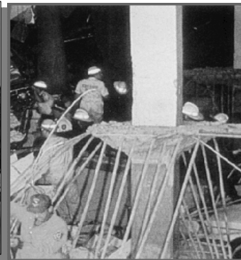
การวิบัติแบบแรงเฉือนเจาะทะลุ
