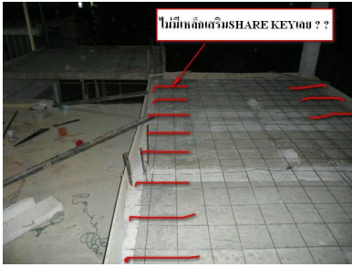
ตำแหน่งที่ควรติดตั้งเหล็ก Shear Key เพื่อยึดแผ่นพื้น
