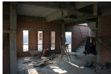
ผนังก่ออิฐส่วนต่อกับเสาต้องเสียบเหล็กหนวดกุ้ง ระยะ 0.40 เมตร และต้องมีเสาเอ็นและทับหลังยึด
