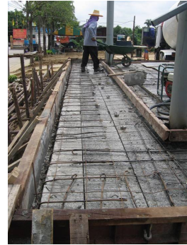
แสดงการติดตั้ง Shear Key โดยรอบ
