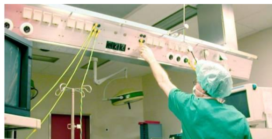
ภาพแสดง การติดตั้งกราวด์ Redundant Ground Jack
