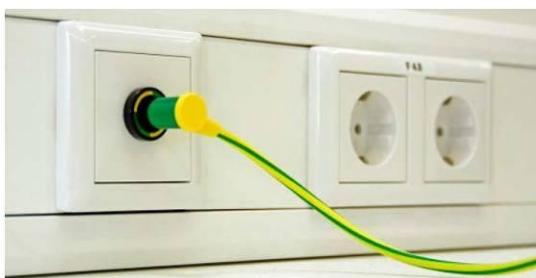
ภาพแสดง การติดตั้งกราวด์ Redundant Ground Jack
