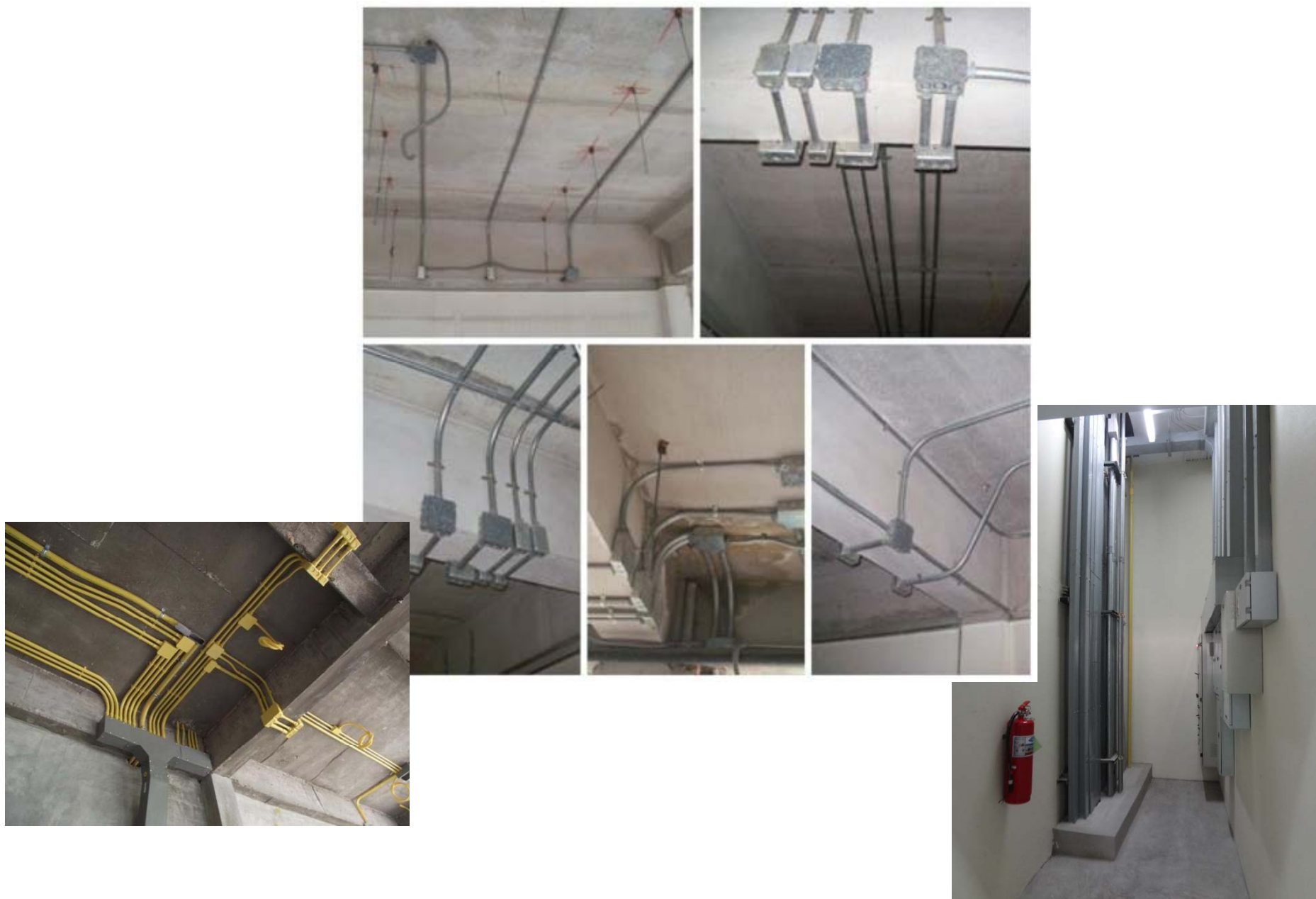
๑๔.๖ การเดินสายไฟยึดแน่นหรือฝังผนัง/ฝ้าอย่างเป็นระเบียบ
