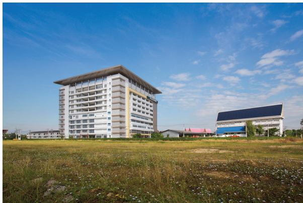
ภาพที่ 2 สภาพภายนอกอาคารด้านทิศตะวันออก
